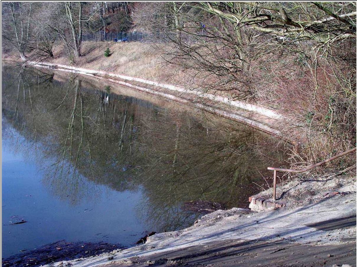
Abbildung 5: Das Westbecken mit Anfang Februar überfluteter Flachwasserzone und der Mauer Foto: Thomas Jenkel
