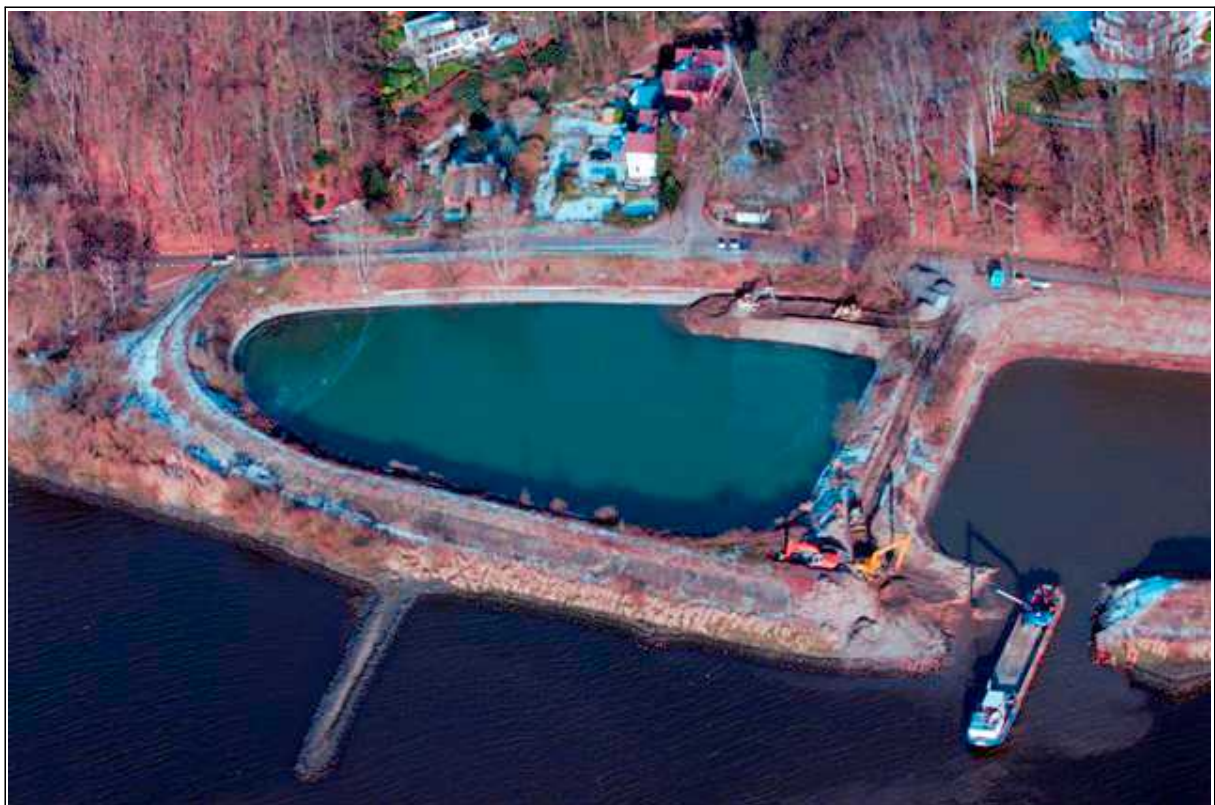
Abbildung 2: Arbeiten an den Wasserbecken Ende 2010, Luftaufnahme.
