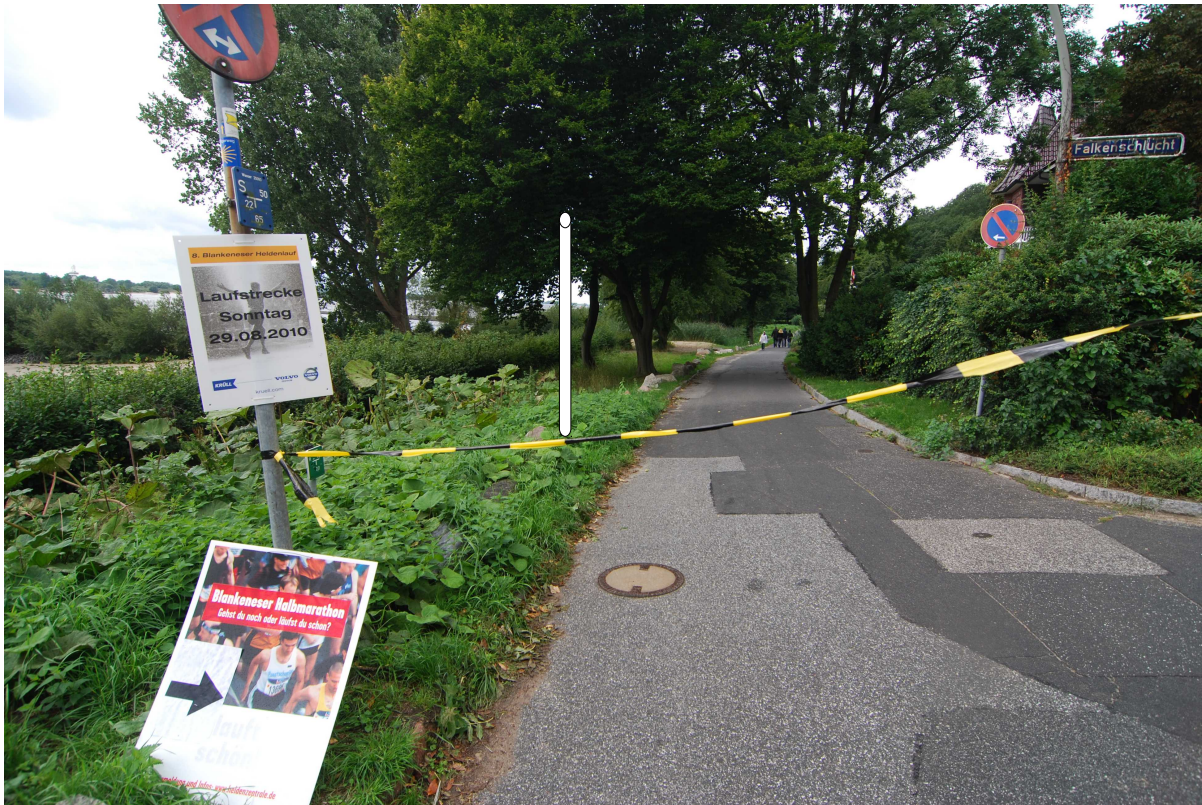
Pos. 9: Falkensteiner Ufer Ecke Falkenschlucht, Aufstellung eines Schildermastes
