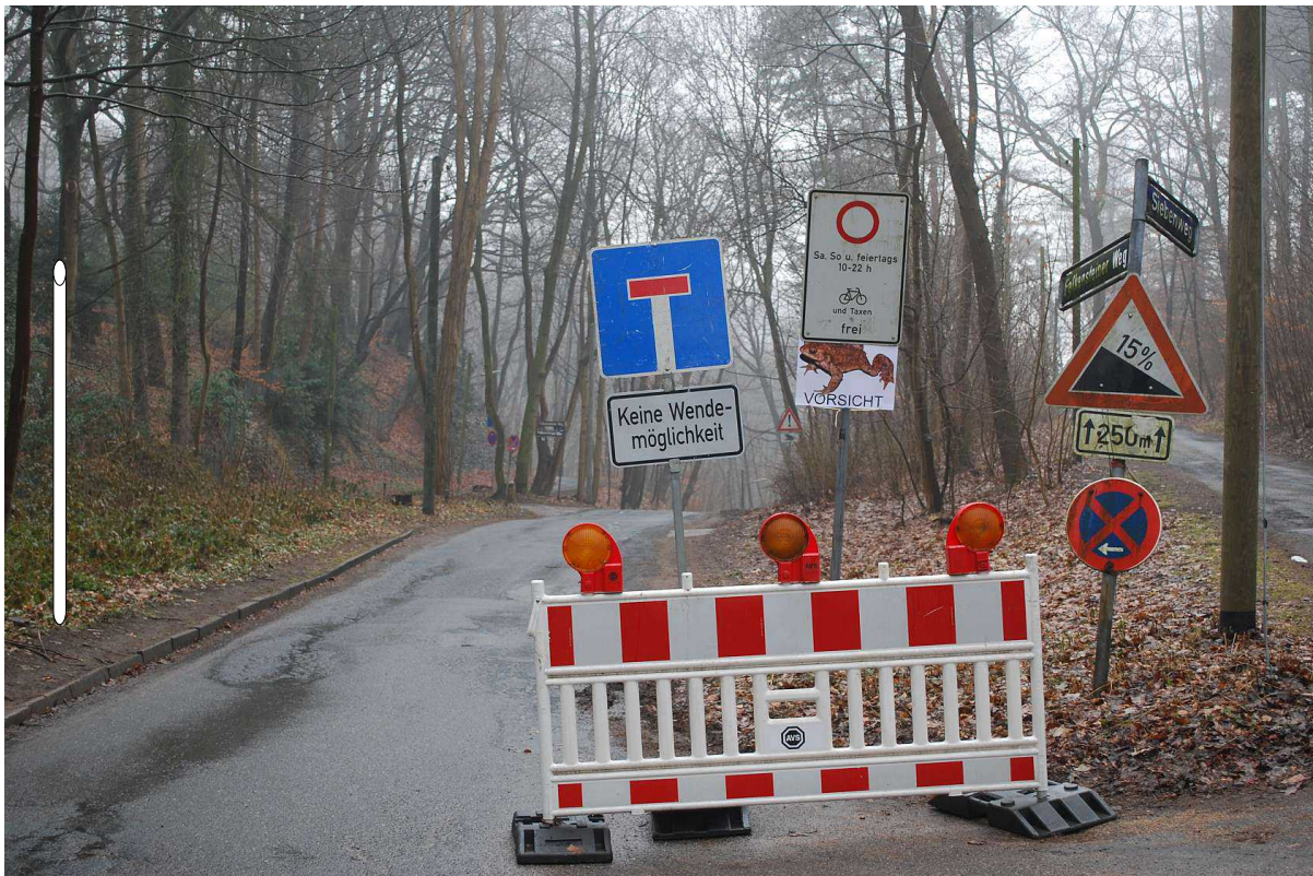
Pos. 10: Falkensteiner Weg (oben), das Schild im Hintergrund ist bei Zufahrt zum Falkensteiner Weg nicht wahrnehmbar. Aus Wahrnehmungsgründen wird vorgeschlagen zusätzlich ein nicht offizielles Schild auf der linken Straßenseite aufzustellen und dafür einen neuen Schildermast anzubringen.
